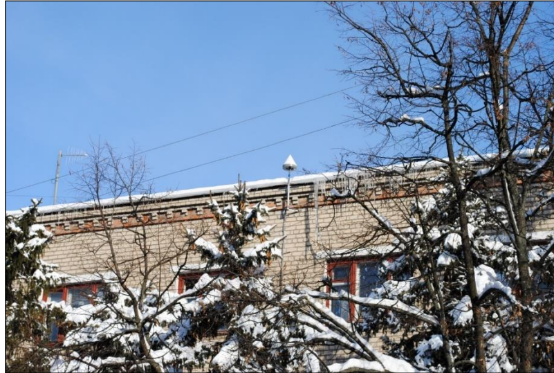
Рисунок 2.2 – Будівля на якій встановлена постійно діюча базова станція у місті Ізюм
