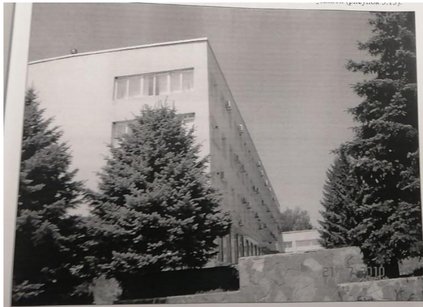
Рисунок 2.4 – Будівля на якій встановлено постійно діючу станцію у місті Красноград
