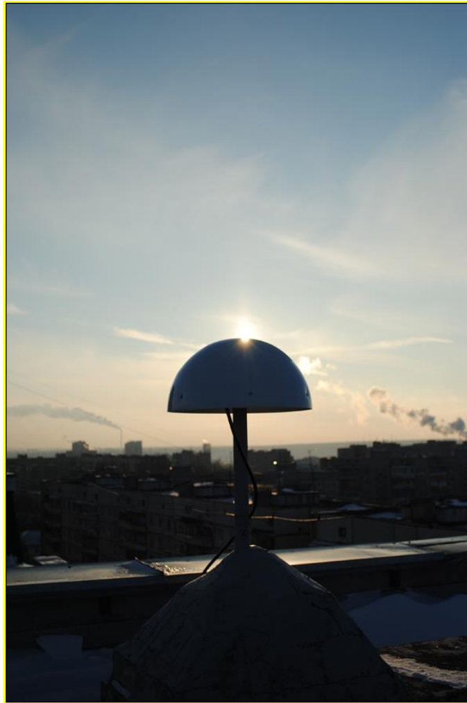
Рисунок 2.7 – Кріплення антени постійно діючої базової станції у місті Харків
