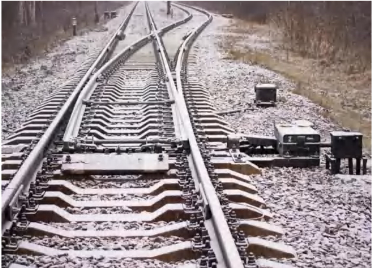
Рисунок 1.21 – Стрілочний перевод
