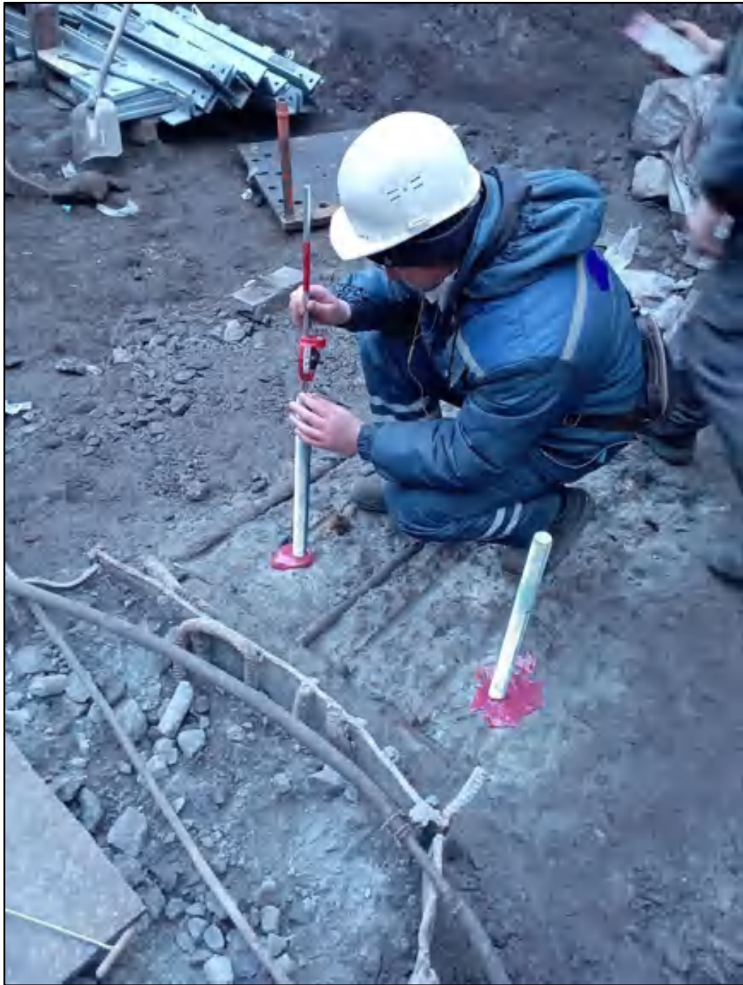
Рисунок 3.30 – Процес виносу центрів « Анкерів »
