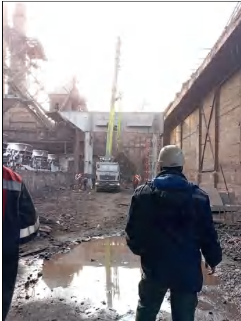
Рисунок 3.31 – Встановлення металевих колон
