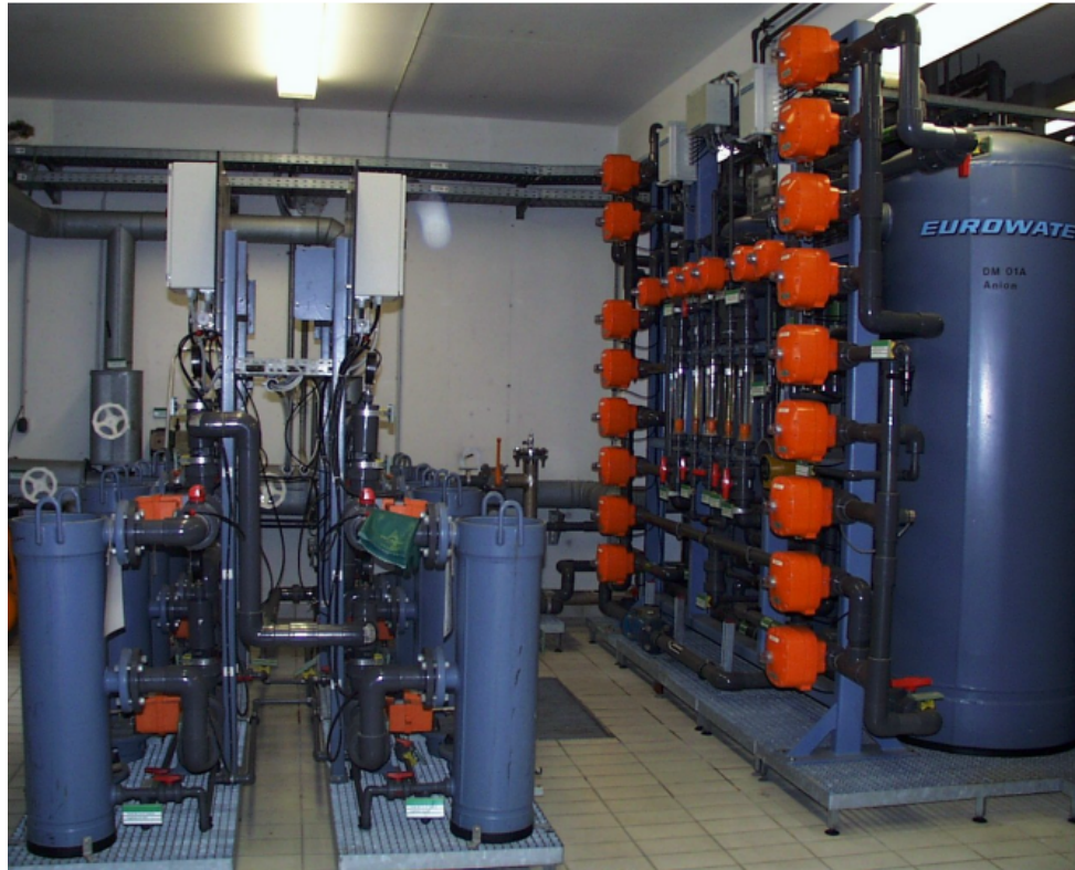
Рисунок 2.18 – Блок фільтрів хімічного очищення
