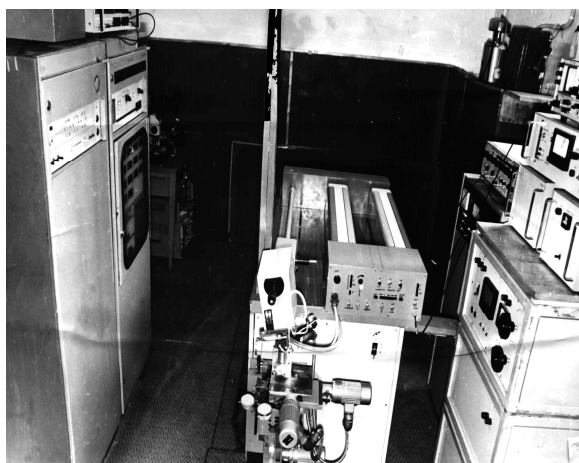
Рис. 9. Лазерна установка для обробки ріжучих пластин із полікристалічних надтвердих матеріалів (ПНТМ)
