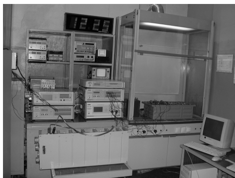
Рис. 8. Автоматизированный стендовый комплекс для диагностирования и испытаний электрохимических аккумуляторов
