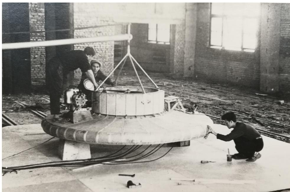
*Определение зависимости давления ВП от давления вентилятора*
