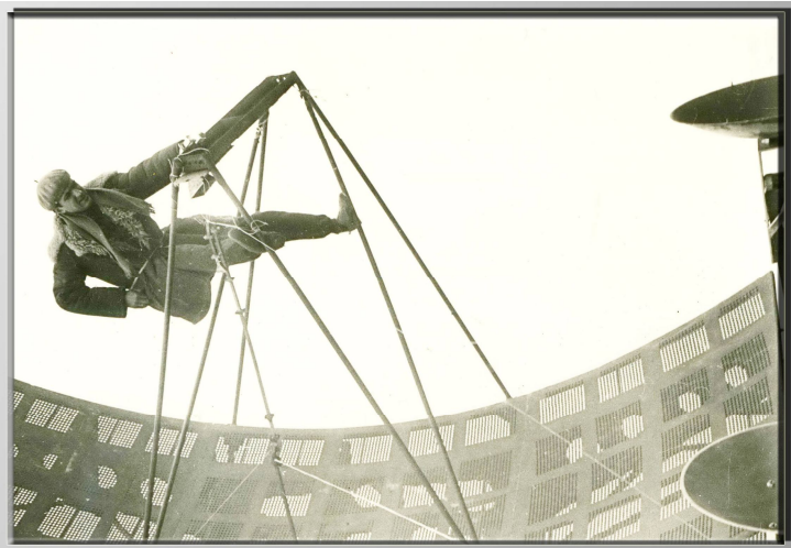
Монтаж антенны радиолокационной станции, Геленджик (1971 г.)
