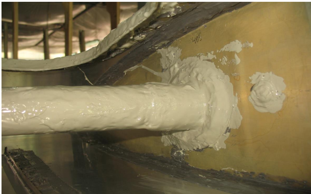
Рисунок 4.4 а) нанесення герметика на заклепки; б); в) нанесення герметика на заклепки всередині бака.
