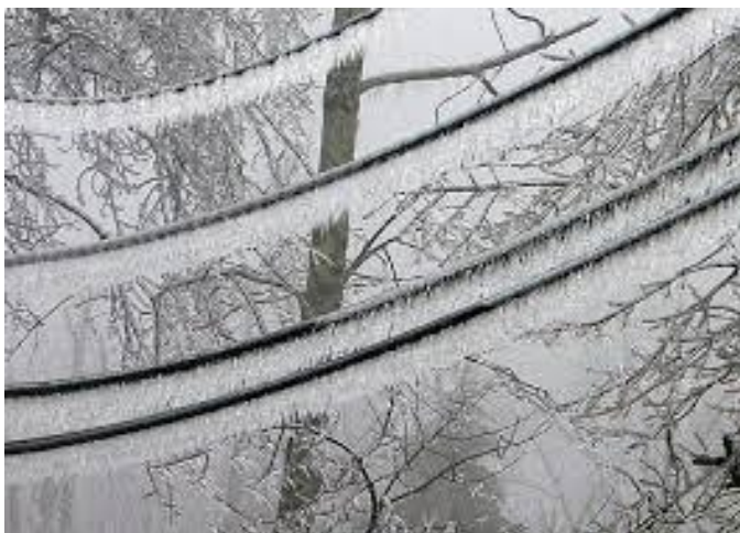
Рисунок 17. Обмерзання електричних проводів
