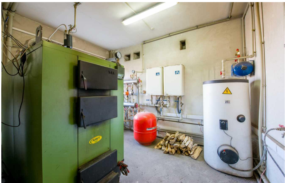
Рисунок 4.3 – Комбінована система опалення
