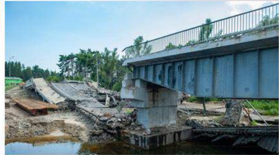
Рис. 3 - Процес прокладення понтонної переправи
