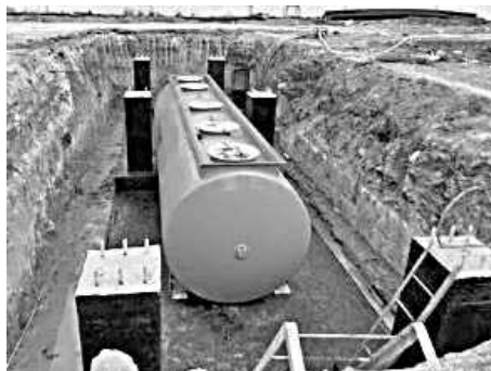
Рисунок А.12 – Резервуар для зберігання палива і нафтопродуктів підземного типу
