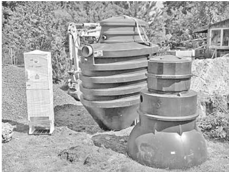
Рисунок А.10 – Автономна каналізаційна система типу Delfin PRO
