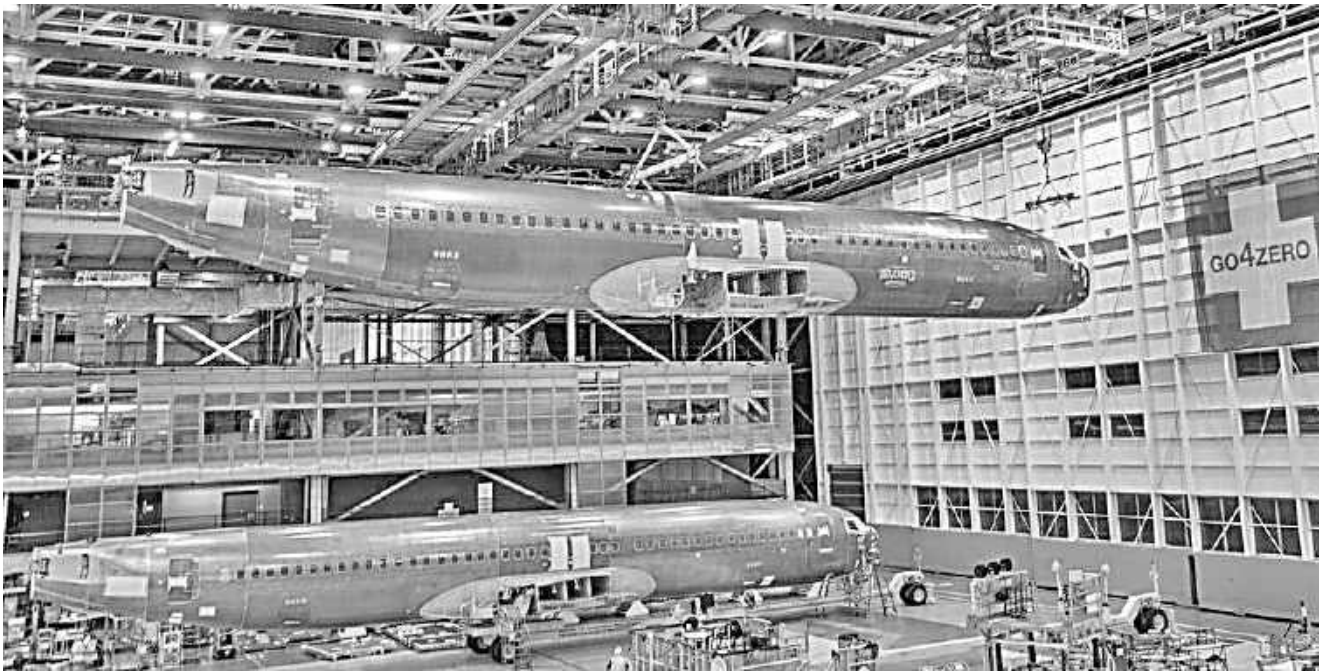
Рисунок 160 – Центроплан, аварійні виходи над крилом і ніша основних стояків шасі літака Boeing 737 MAX [157]
