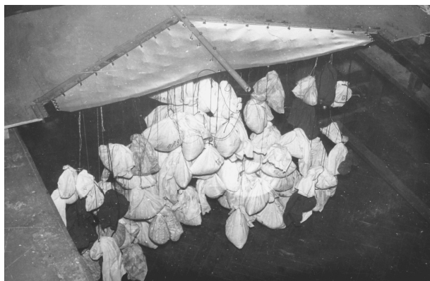
Рис. 5. Первые статические испытания гибкого крыла
