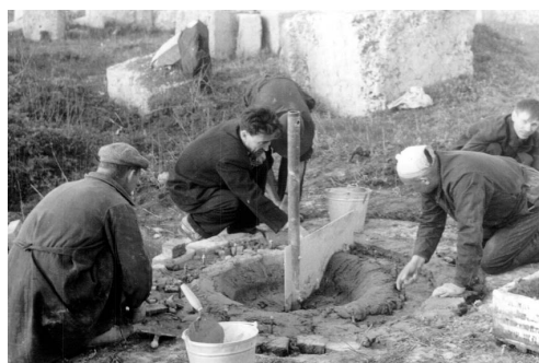
Рис. 3. Р.В. Пихтовников (крайний справа) самостоятельно делает бетонную матрицу для получения деталей (в центре аспирант В.К. Борисевич)
