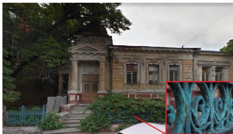
Рисунок 5.5 - Огорожа на території будівлі
