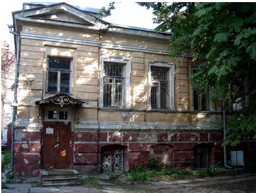
Рисунок 5.3 - Актуальний вигляд будівлі
