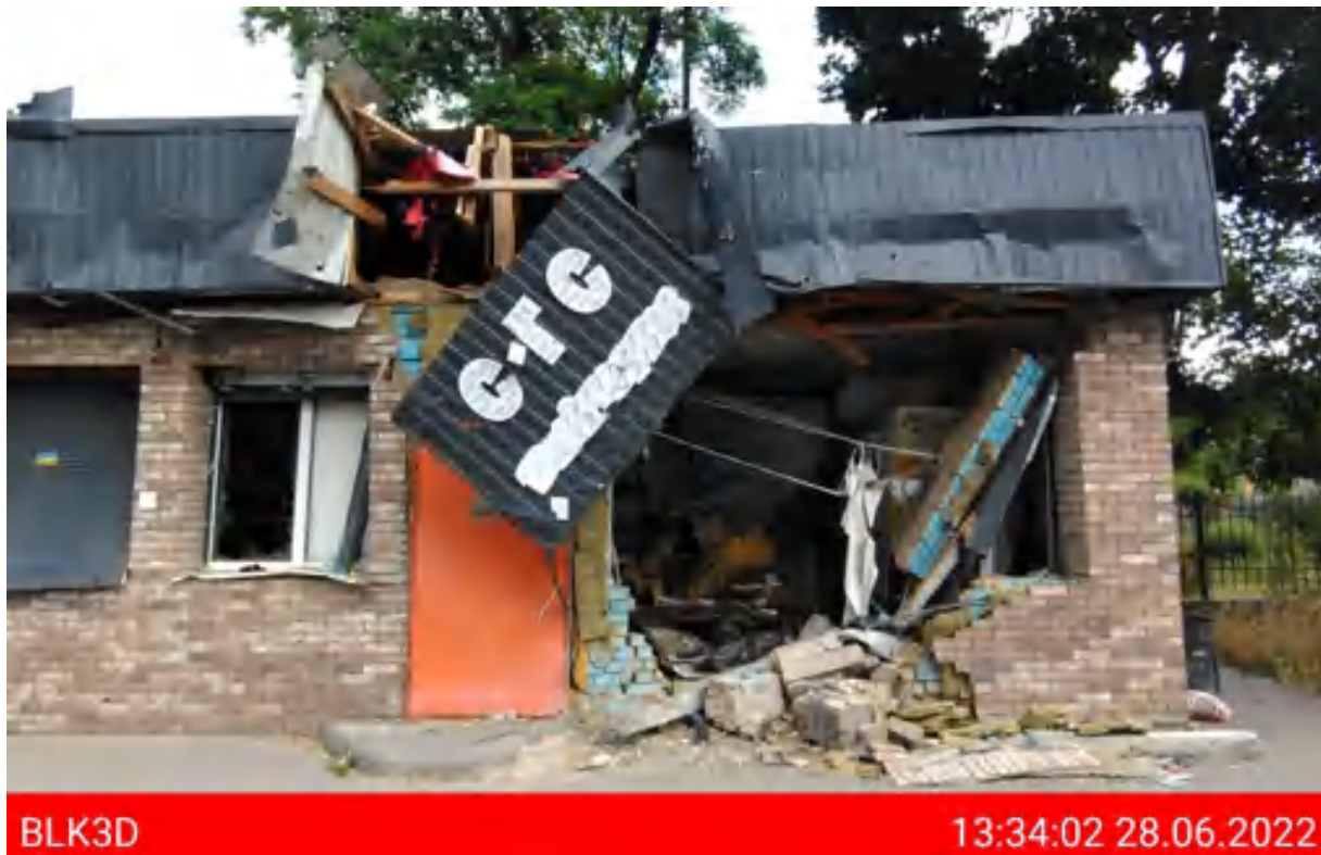
Рисунок 2.14 – Звіт із зруйнованого об'єкту за допомогою 3D далекоміра Leica BLK3D, м. Ірпінь Київська область
