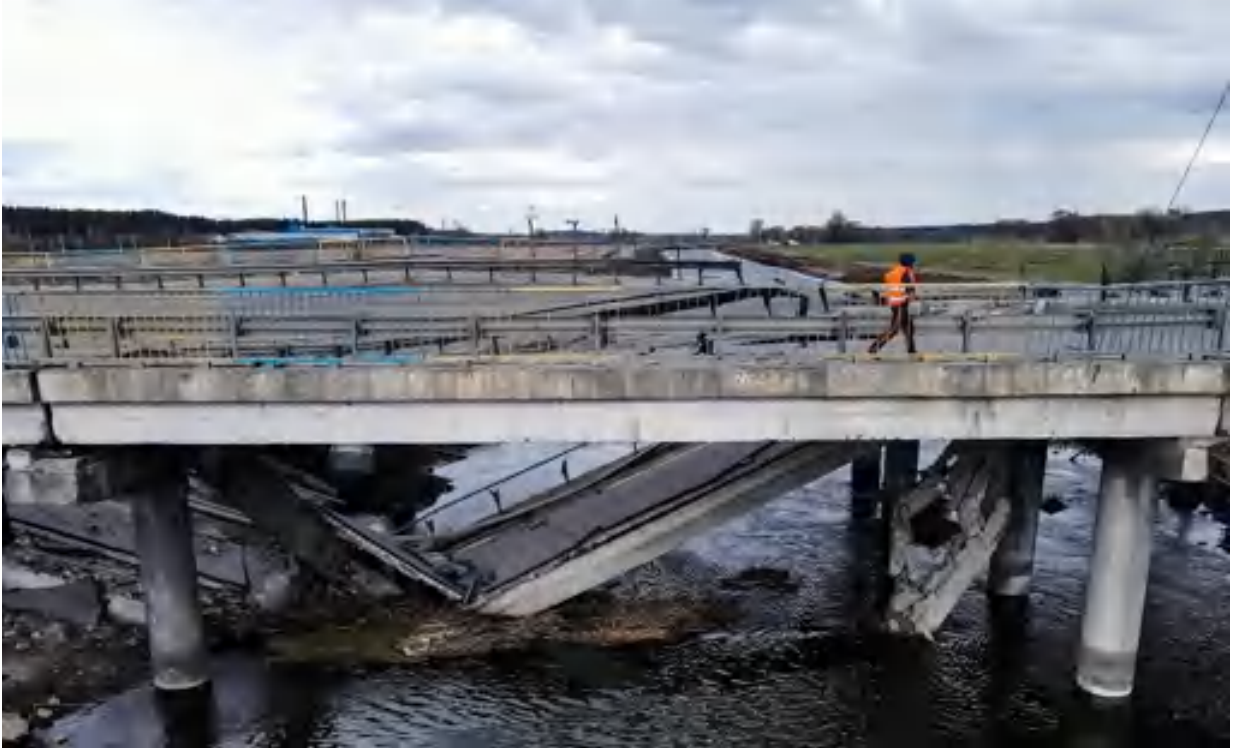
Рисунок 2.5 – Сучасний стан мосту по дорозі Е373 через річку Ірпінь
