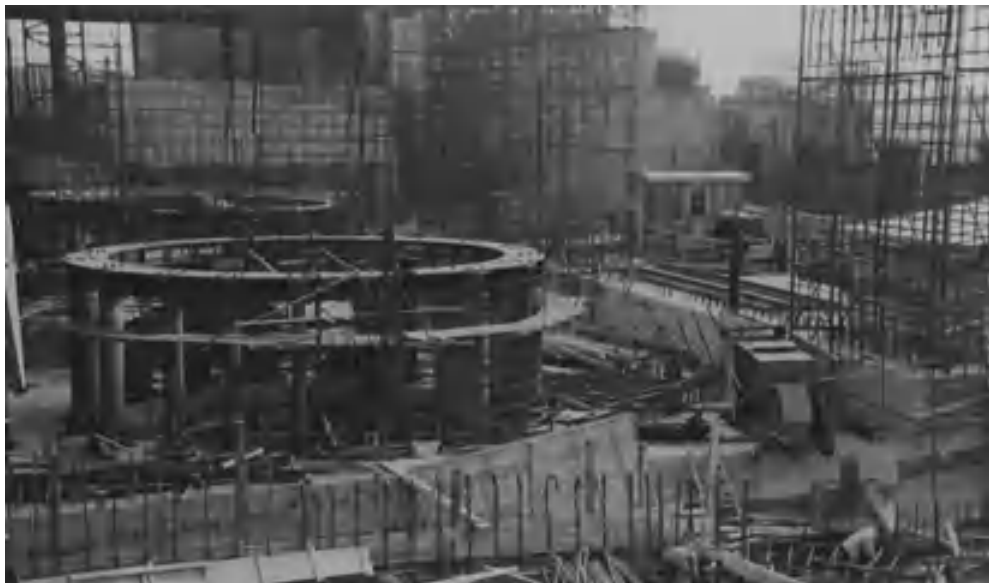
Рисунок 1.4 – Монтаж статора турбіни
