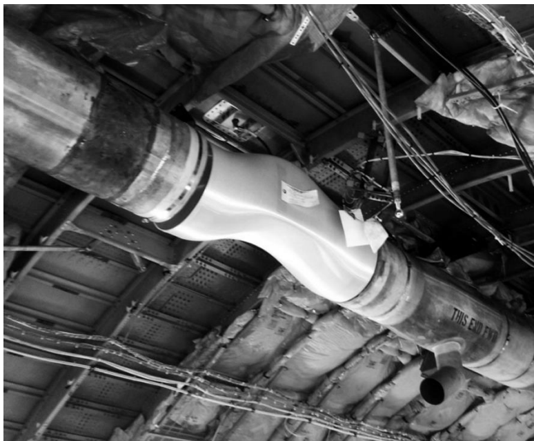
Рисунок 2.1 - Деталь повітропроводу, яка надрукована екструзійним методом
